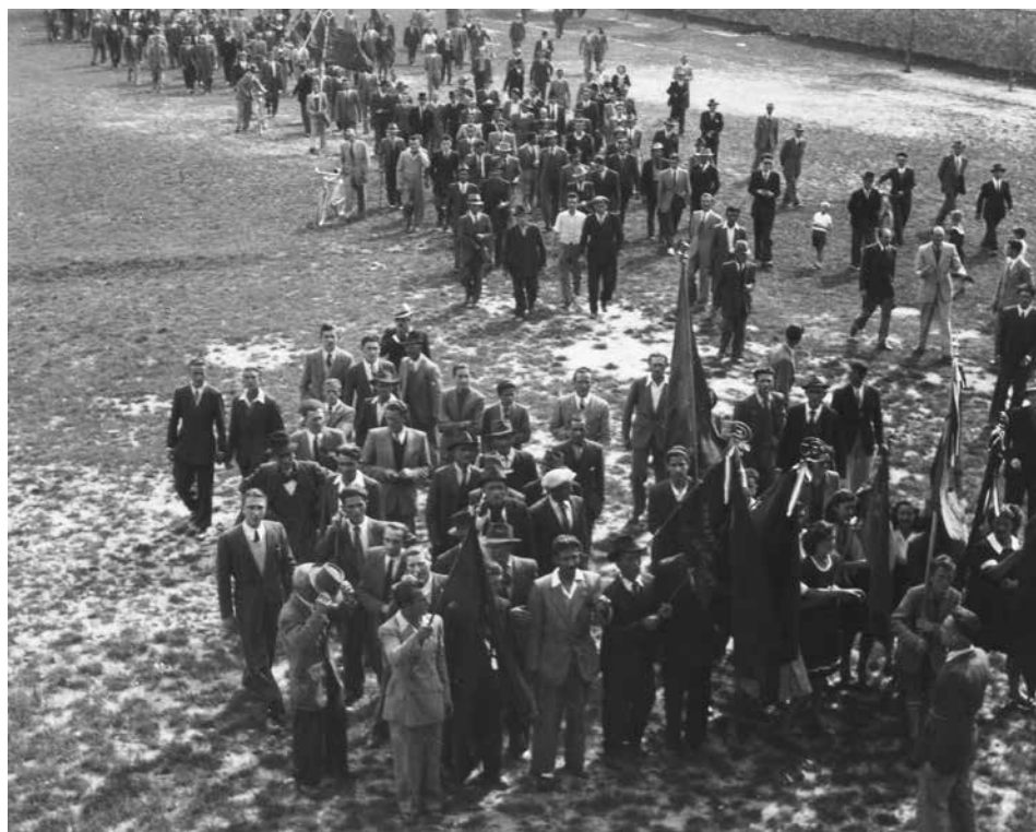
I compagni ascoltano dal cortile della palestra di via Stazione (ora demolita).
