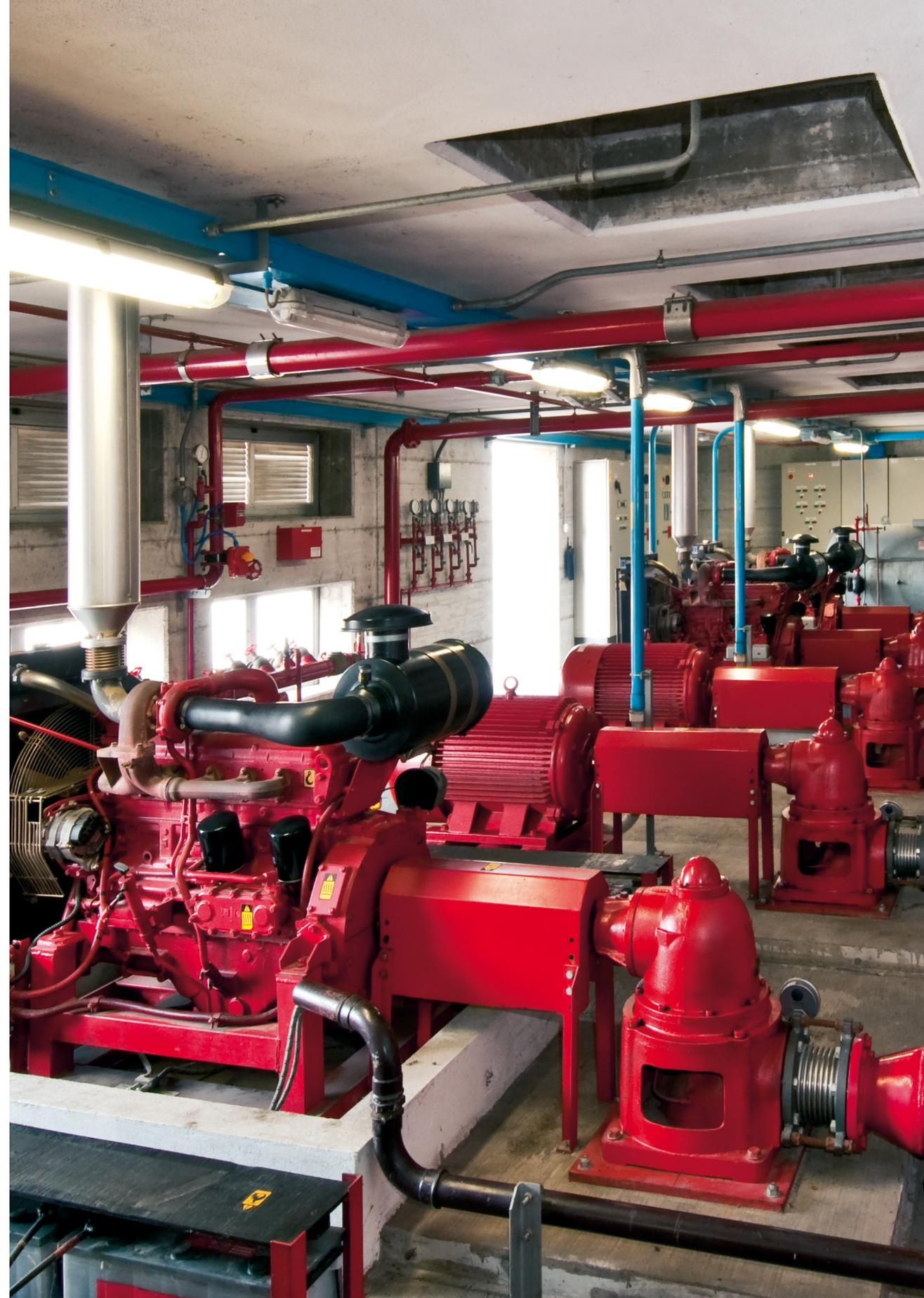
o lavorate nei vari impianti vengono utilizzati diversi agenti estinguenti come acqua, schiuma e polveri. Lo stabilimento di Offanengo dispone di un avanzato sistema antincendio automatico composto da una riserva d'acqua pari a 2500 metri cubi, di una stazione di pompaggio completamente automatica e da una fitta rete di tubazioni che distribuisce l'acqua antincendio in tutto lo stabilimento.
