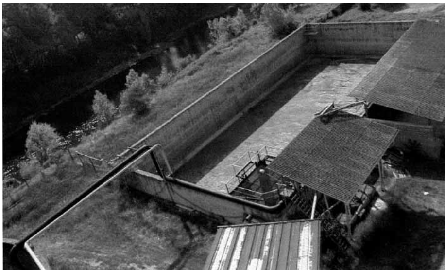
Italrettile. Impianto depurazione
